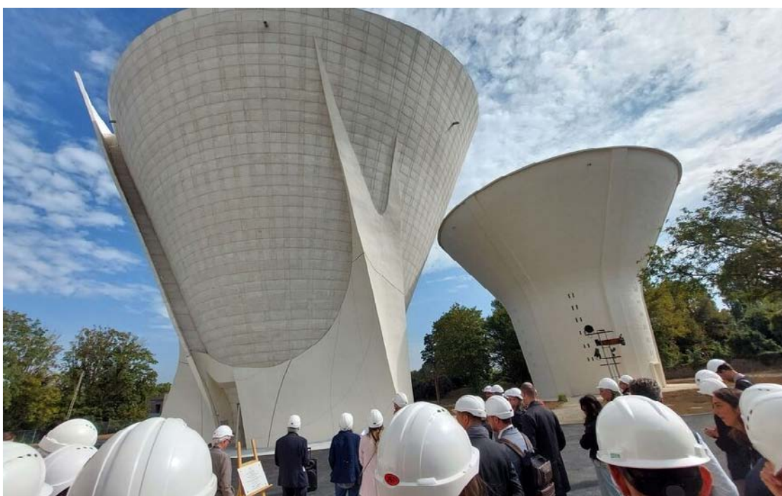
Palaiseau (Essonne), le 20 septembre. Le château d'eau, baptisé R3, a été inauguré vendredi. Il doit contribuer à faire face aux besoins en eau, qui devraient tripler dans le secteur d'ici à 2030. LP/C.C.
